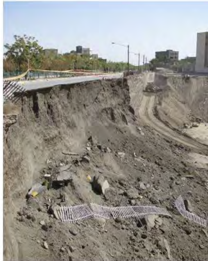
(الف) ریزش دیواره و خسارت به خیابان مجاور
