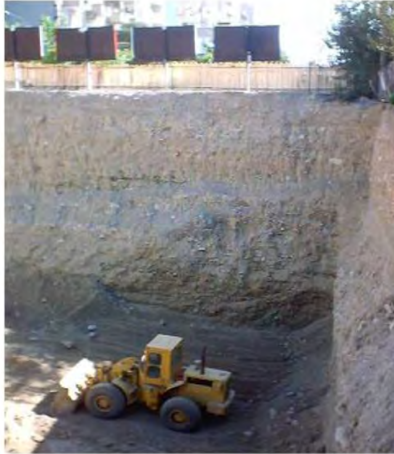
(الف) گودبرداری غیر اصولی به صورت دیواره قائم
