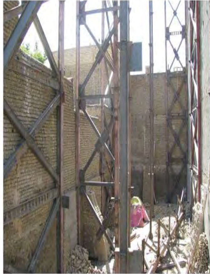
(الف) اجرای اسکلت پس از گودبرداری بدون اجرای سازه نگهبان و نشست ساختمان‌های مجاور (ب) اجرای سازه نگهبان غیراصولی (منبری) و نشست
