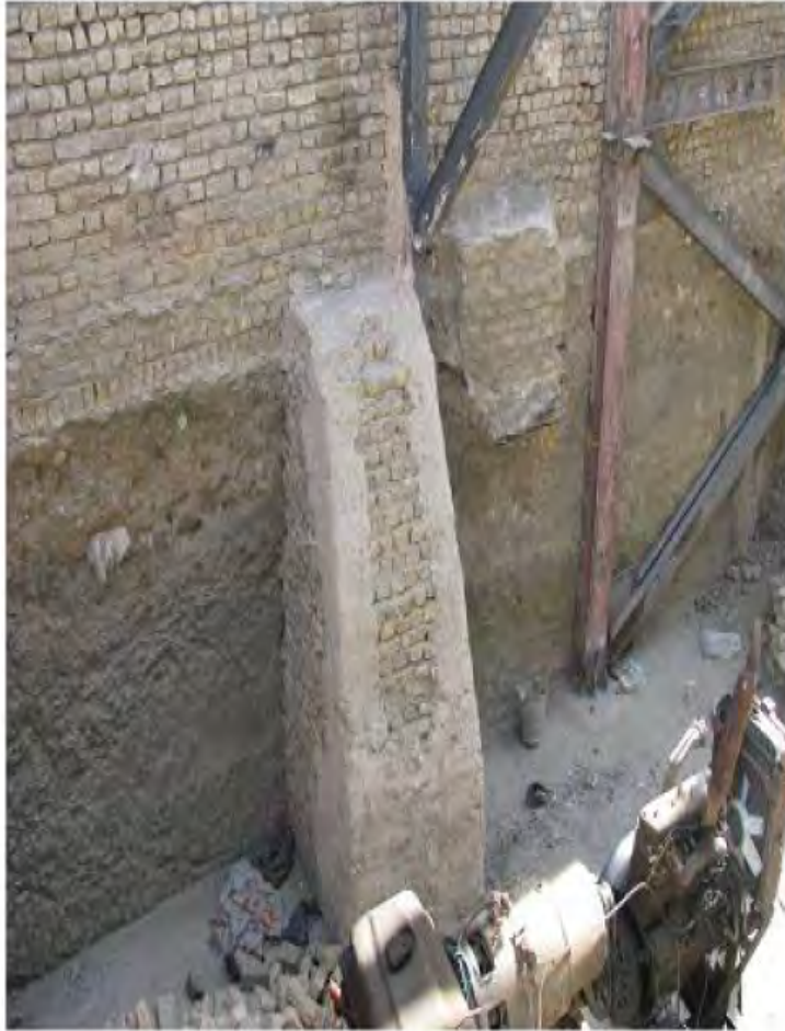
(الف) اجرای اسکلت پس از گودبرداری بدون اجرای سازه نگهبان و نشست ساختمان‌های مجاور (ب) اجرای سازه نگهبان غیراصولی (منبری) و نشست
