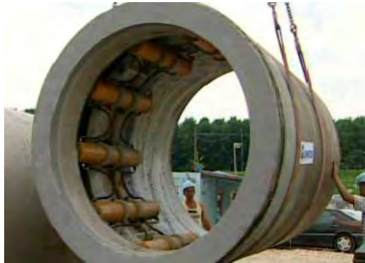
شکل ۵-۱۰-۴- لوله بتنی مخصوص عملیات لوله رانی
