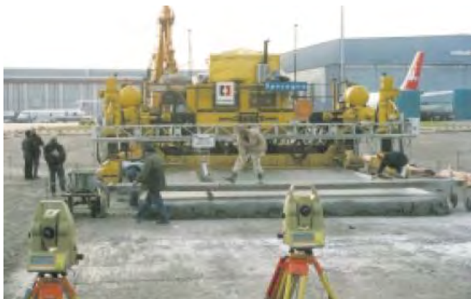
شکل ۲-۱۸-۹- استفاده از سیستم بدون سیم
