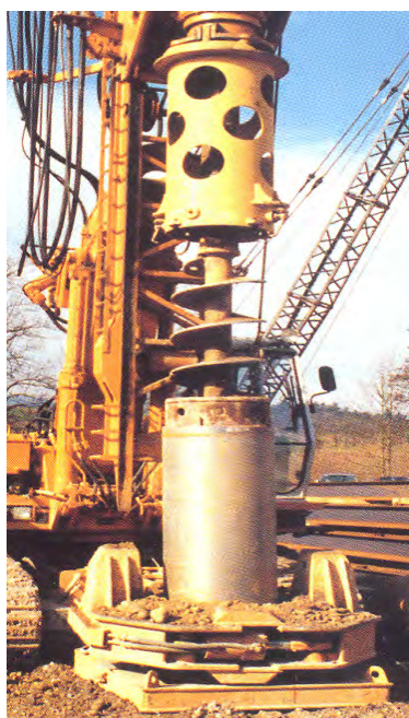
شکل ۳-۴-۸- اوگر با لرزاننده لوله
