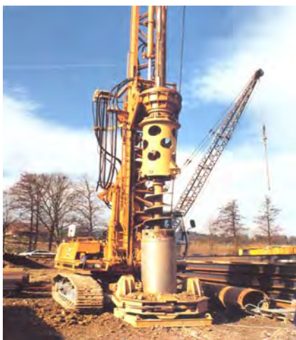
شکل ۳-۴-۶- استفاده از اوگر برای حفاری قایم
