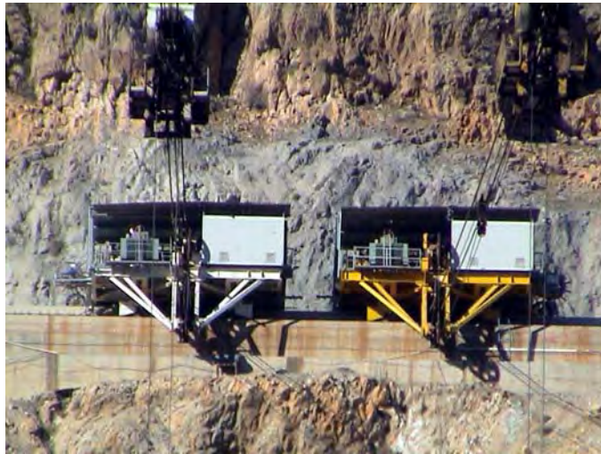
شکل شماره ۶-۶-۴- نمایی نزدیک از واگن‌های اصلی سیار جرثقیل کابلی موازی کارون ۳ (جناح راست)
