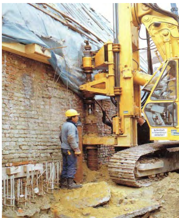
شکل ۳-۴-۱۰- حفاری با اوگر در مجاورت دیوار
