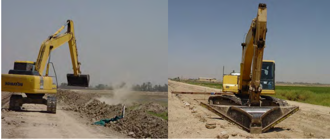
شکل ۲-۱۰-۱ (الف) بیل برای زاویه دادن به کانال‌های بزرگ (ب) بیل ذوزنقه‌ای برای حفر کانال‌های کوچک
