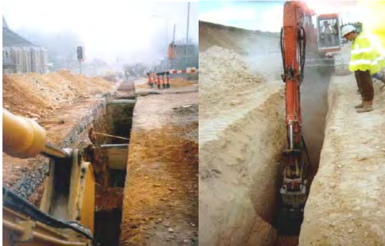
شکل ۳-۵-۳- کاربرد باکت حفار در حفر ترانشه
