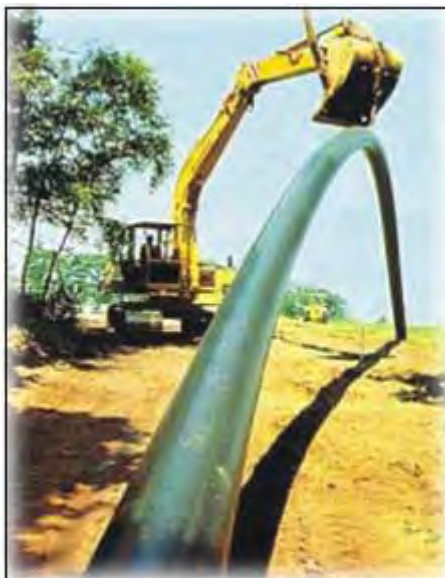
شکل ۵-۹-۲- نمونه کاربرد لوله پلی اتیلن در آبرسانی
