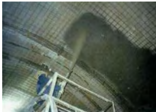
شکل ۴-۱۸-۲- استفاده از شاتکریت برای نگهداری فضاهای زیرزمینی
