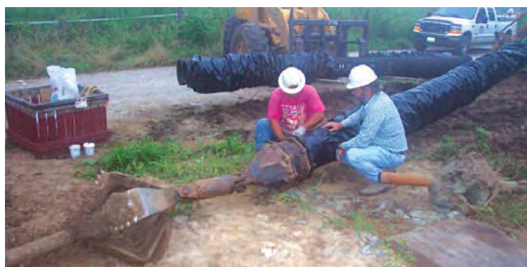
شکل ۳-۲۹-۷- نصب لوله به راد
