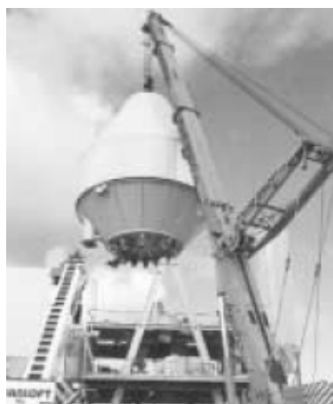
شکل شماره ۴-۳-۵- دیگ بچینگ در حال نصب
