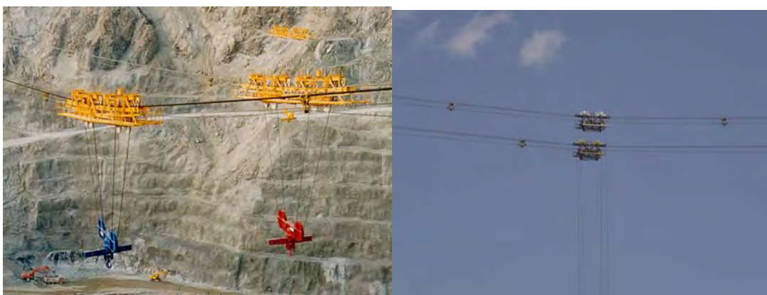
شکل ۶-۶-۹- سیم بکسل‌های جرثقیل کابلی
