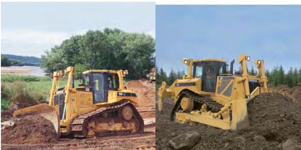
شکل شماره ۲-۲-۱- بولدوزر در حین عملیات خاکی
