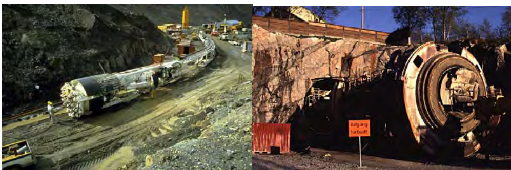
شکل ۳-۳-۱ چند نمونه تی بی ام در حال کار
