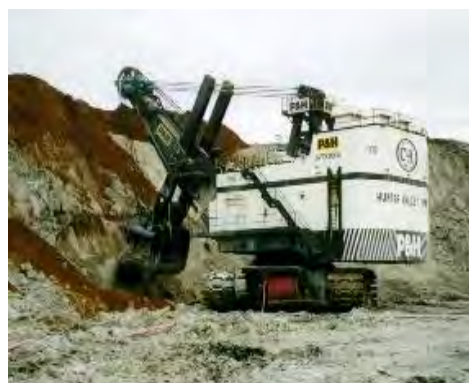
شکل ۳-۱۹-۲- شاول در حال عملیات لایه برداری
