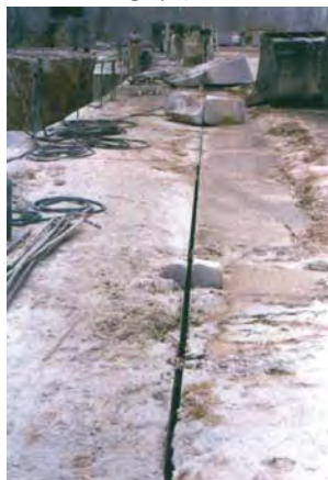
شکل ۳-۱۷-۶- برش ایجاد شده توسط سیم برش الماسه
