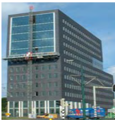
شکل ۶-۱۰-۶- استفاده از mast climbing در نمای شیشه ای
