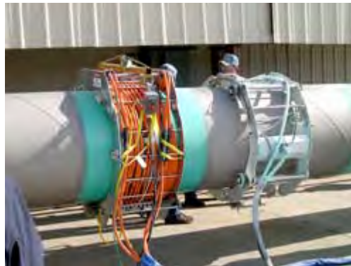
شکل ۵-۴-۸- سیستم پوشش دهی محل اتصال
