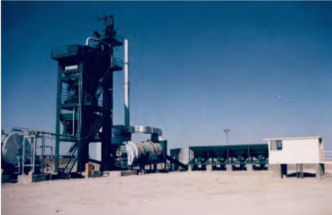
شکل شماره ۲-۲۱-۱- کارخانه آسفالت
