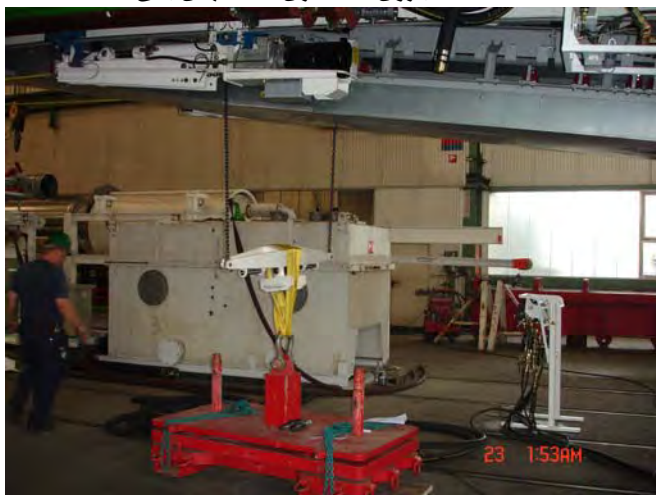
شکل ۳-۳-۲۴. جرثقیل ۲۰ تن حمل سگمنت بتنی
