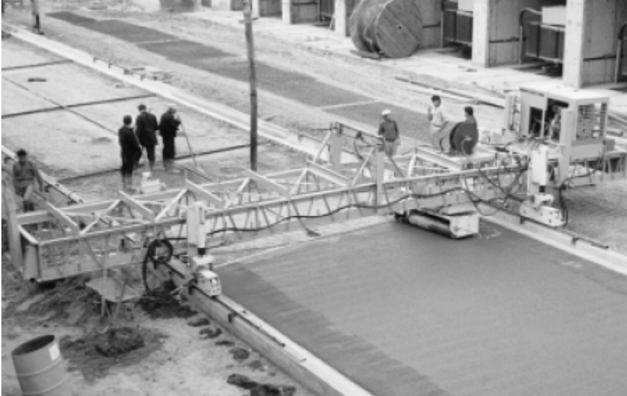
شکل ۴-۱۶-۲- فینیشر سیلندری کوچک در حال روکش کردن یک خیابان شهری
