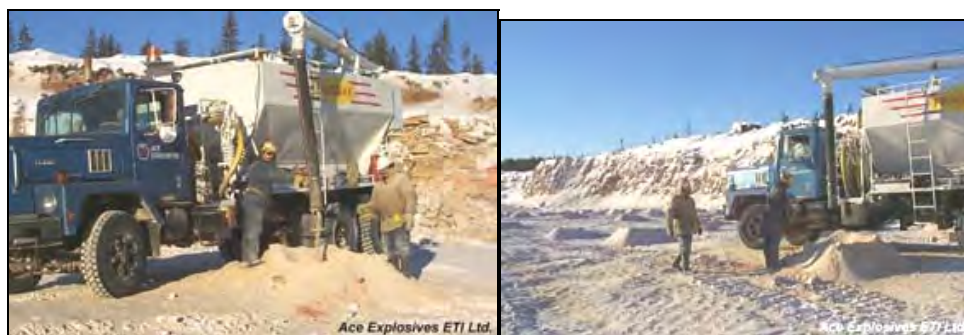
شکل ۳-۲۱-۳- عملیات خرج‌گذاری با استفاده از کامیون با سیستم خروجی اوگر
