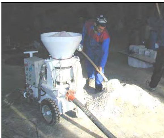
شکل ۴-۱۸-۴- نحوه ریختن مصالح در دستگاه پمپ شاتکریت
