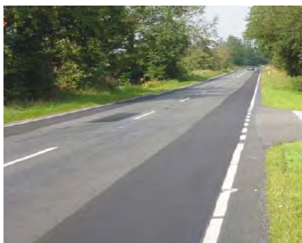
شکل شماره ۲-۲۰-۳- لکه گیری جاده ها
