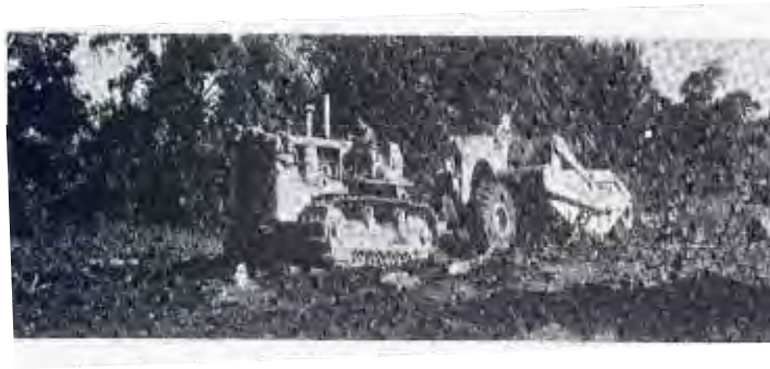
شکل ۲-۶-۶. اسکرپور با تراکتور چرخ زنجیری
