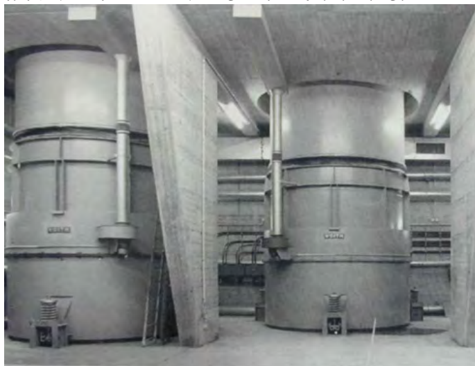
شکل ۶-۱۴-۹- بادبزنی محوری قائم در تونل Elbe آلمان
