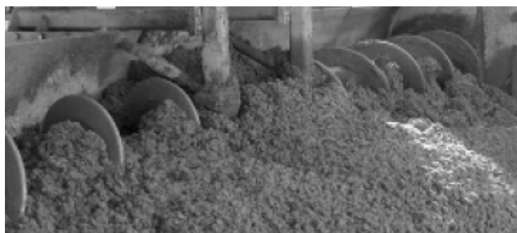
شکل ۴-۱۶-۸- پخش کردن بتن توسط تیغه ماریچ
