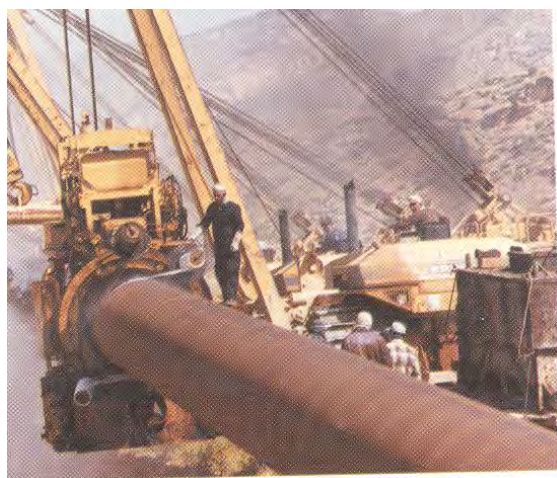
شکل ۵-۴-۶- دستگاه اتوماتیک نوار پیچی
