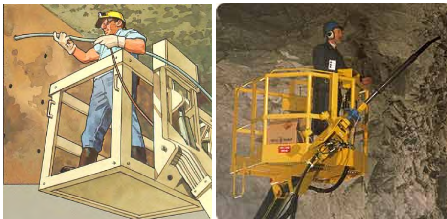
شکل ۳-۲۸-۱۱ خرجگذاری از داخل سبد دستگاه آنفوشارژر
