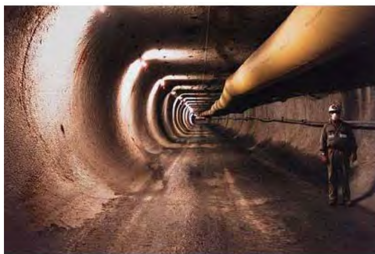
شکل ۲-۲۳-۳- نمای از تونل حفر شده با ماشین Mobile Miner
