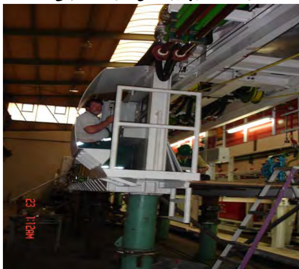
شکل ۳-۳-۲۵. کابین کنترل دستگاه واقع در یک آب دستگاه. لازم به ذکر است اپراتور در این قسمت صرفاً کنترل حرکت دستگاه و کاتر را بر عهده دارد و به دلایل ایمنی و عدم دید کافی کنترل بخش سگمنت گذاری به صورت دستی و از نزدیکی بازوی مربوطه انجام می‌شود.
