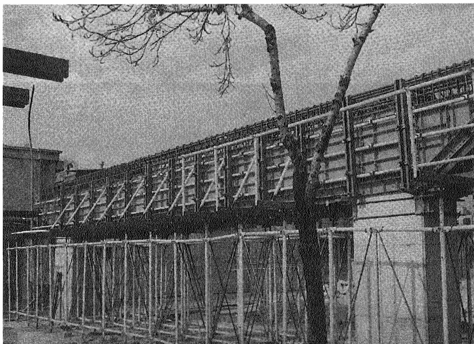
شکل ۸-۹ داربست‌بندی واقعی در زیر تیر سنگین.
