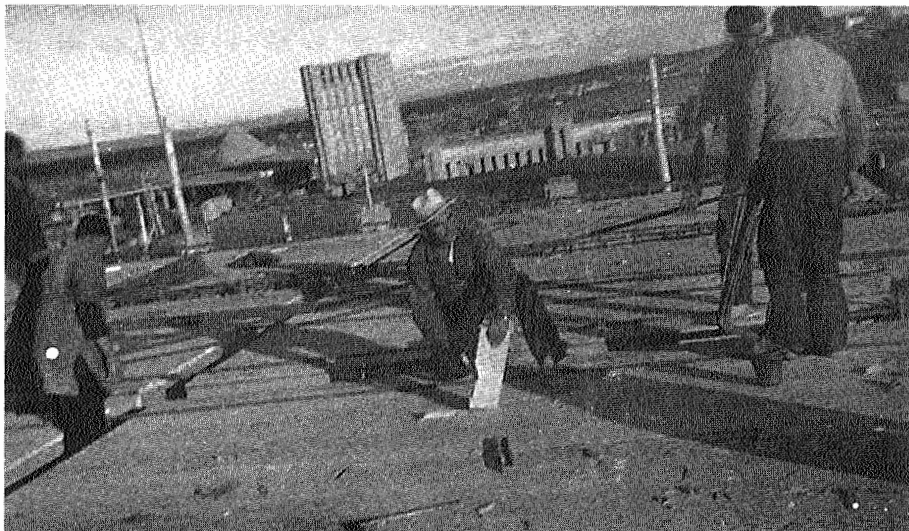
شکل ۱-۲ قالب بندی سنتی با چوب.
