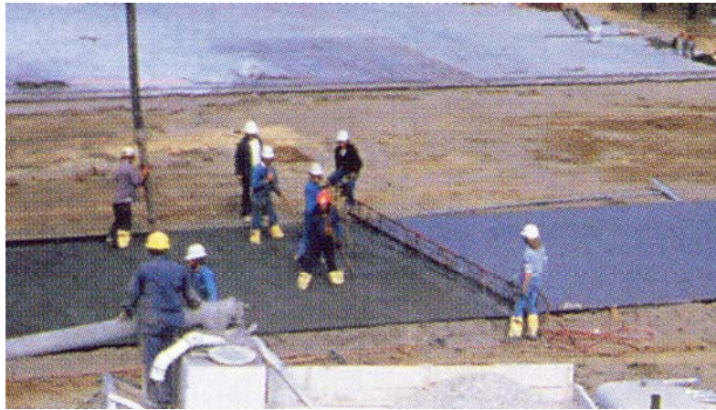
شکل ۱ استفاده از شمشه برای تراز کردن سطح یک دال
