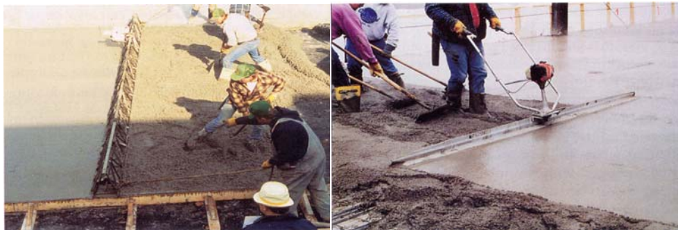
شکل ۲ استفاده از شمشه های دارای ویبره برای تراز کردن و متراکم نمودن سطح، به صورت همزمان
