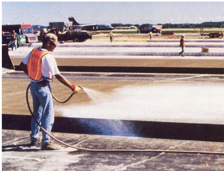
شکل ۴ روش عمل‌آوری با ماده شیمیایی غشایی
