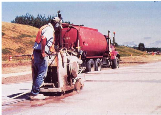
شکل ۱ استفاده از دستگاه برش برای ایجاد درز
