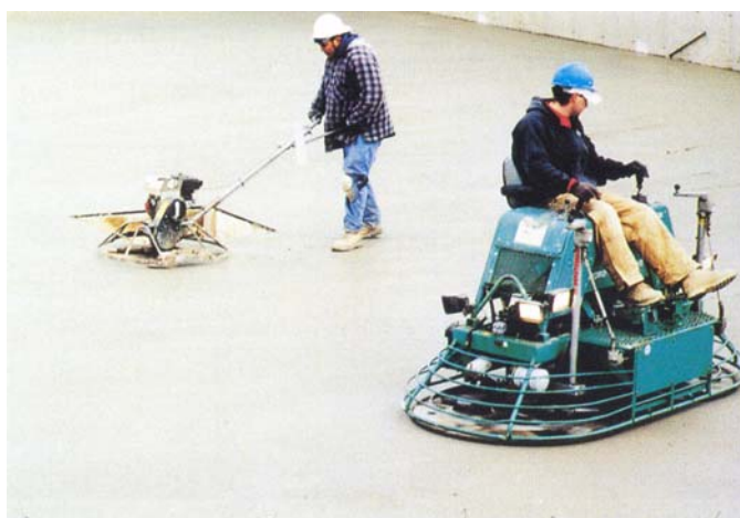
شکل ۶ پرداخت نهایی با ابزار مکانیکی
