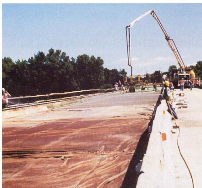
شکل ۱ عمل‌آوری با پارچه چتایی و خیس کردن متوالی آن
