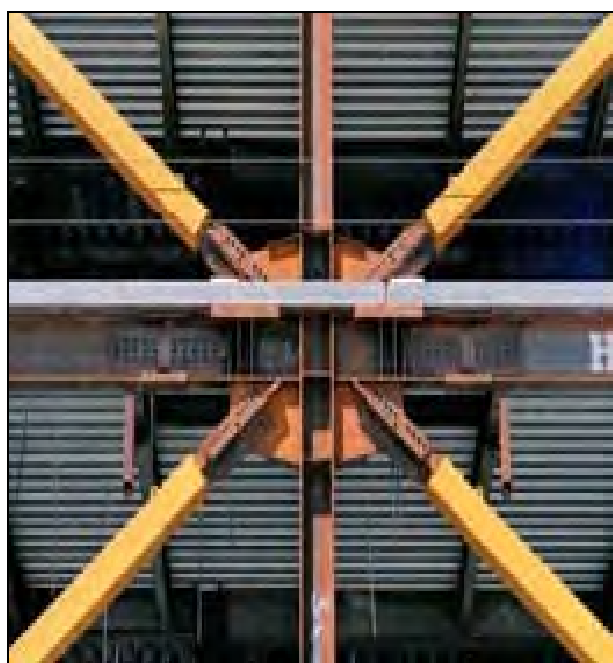
شکل ۴-۱۹- نمونه‌هایی از مه‌اربند ضد کمانش BRBF
