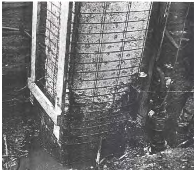
ب- اجرای روکش بتنی با بتن پاشی
