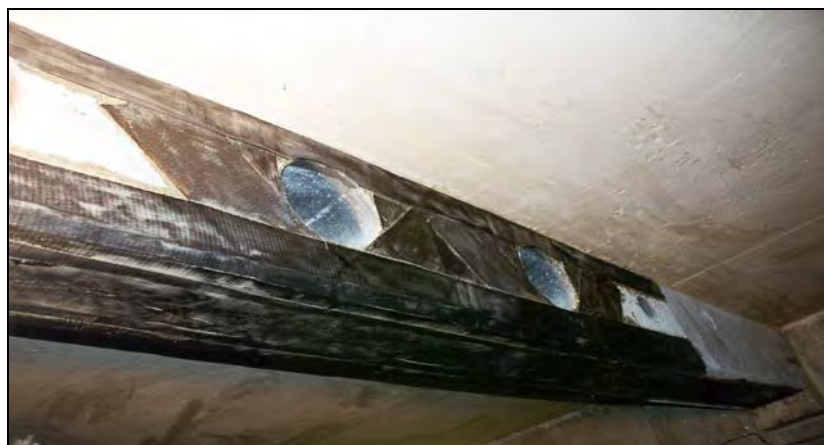
شکل ۲-۴-۱۵- تقویت موضعی سوارخ‌ها در تیر FRP
