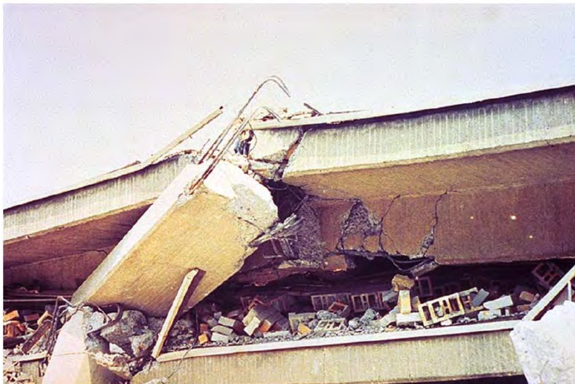
شکل ۲-۶-۱۰ وجود درز سرد در محل اتصال
