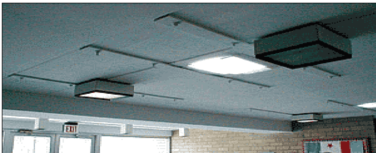
شکل ۲-۳-۷- تقویت دال‌ها با استفاده از ورق‌های فولادی
