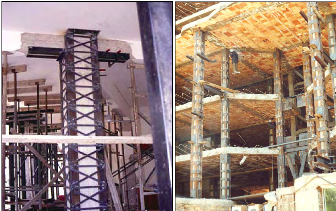
شکل ۲-۵-۱۳- بهسازی ستونهای بتنی بوسیله روکش فولادی قفسه‌ای
