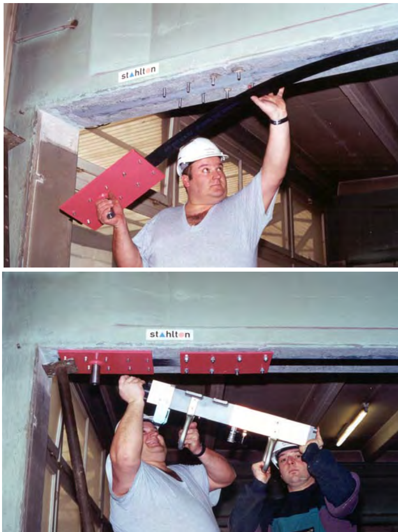
شکل ۲-۴-۱۷- روش پیش‌تنیدگی در صفحه FRP
