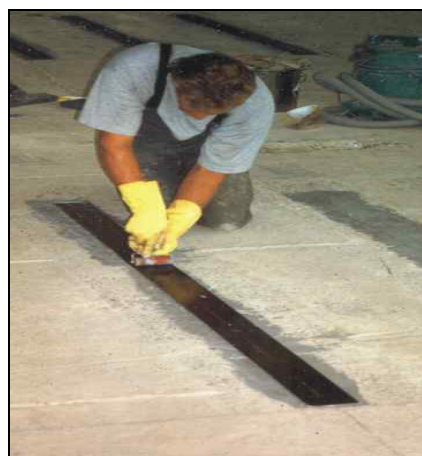
شکل ۱۱-۳-۲- مقاوم‌سازی دال در لنگرهای منفی بوسیله FRP
