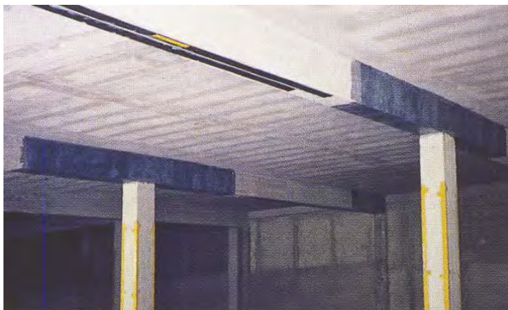
شکل ۲-۴-۸- کاربرد مصالح FRP در مقاوم‌سازی
