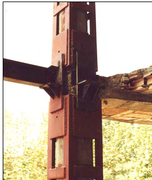
شکل ۲-۵-۱۲- نمونه‌ای از روکش فولادی جهت افزایش مقاومت خمشی ستون
