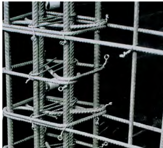
شکل ۳-۱۶- اجرای جزئیات مناسب و شکل‌پذیر در ستون‌ها
