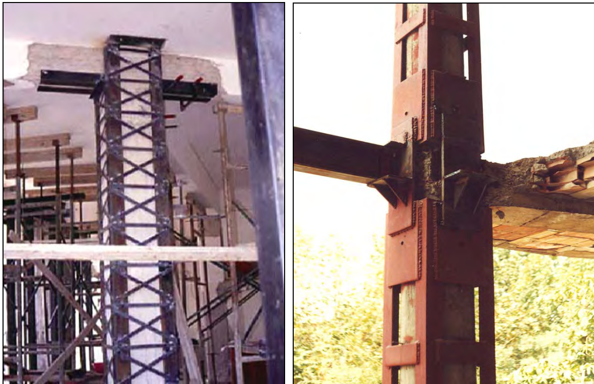
شکل ۲-۶-۲ روش‌های بهسازی اتصالات میانی
