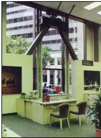
شکل ۷-۱۳- نمونه هایی از بکارگیری میراگر T-ADAS
