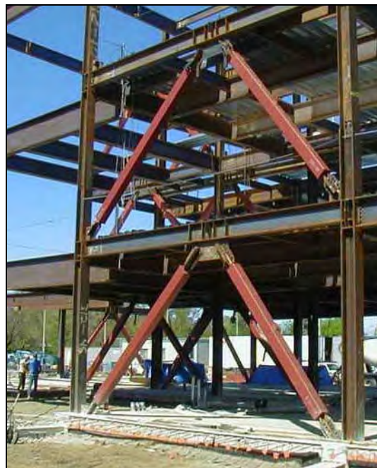
شکل ۴-۱۹- نمونه‌هایی از مه‌اربند ضد کمانش BRBF
