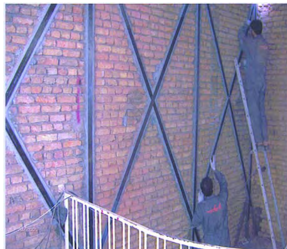
شکل ۸-۱۹ - نحوه اجرا و نصب نوارهای FRP
