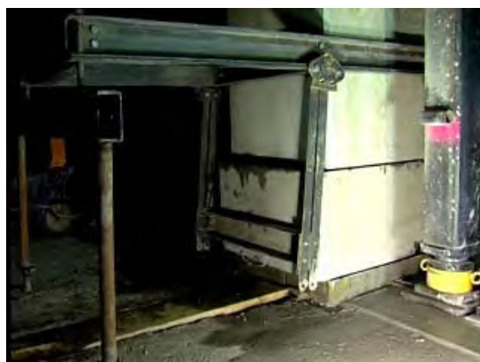
شکل ۶-۱۹ - خروج بلوک بریده شده
