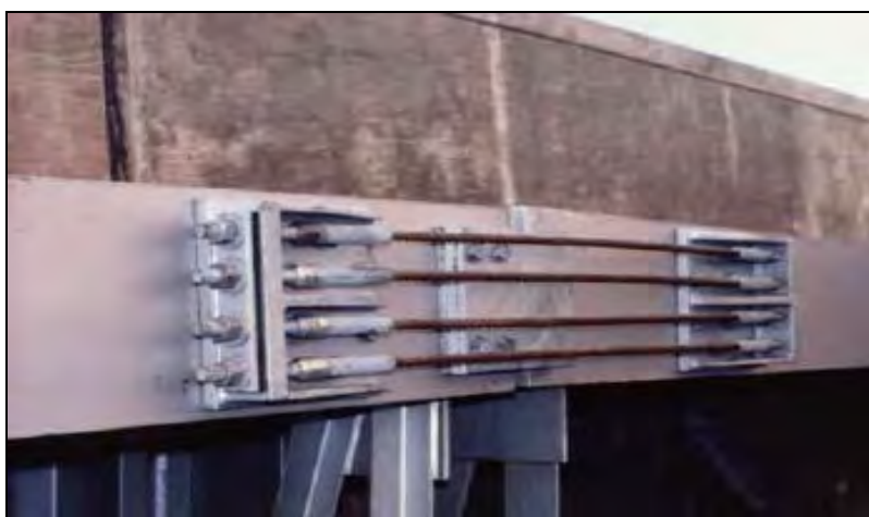
شکل ۲-۴-۲۰- روش استفاده از پیش تنیدگی موضعی در مقاوم سازی تیرهای بتنی
