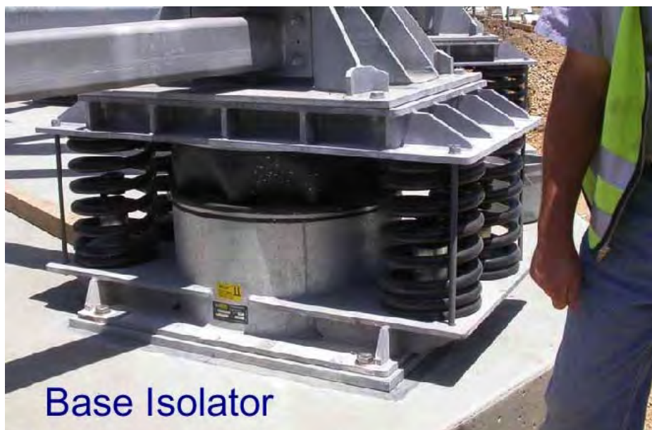
شکل ۶-۱۲- جداگر GERB
