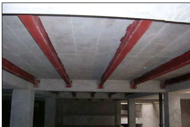
شکل ۲-۳-۵- اضافه کردن تیرک فولادی
