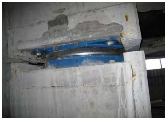
شکل ۶-۱۱ - جداگرهای اصطکاکی FPS
