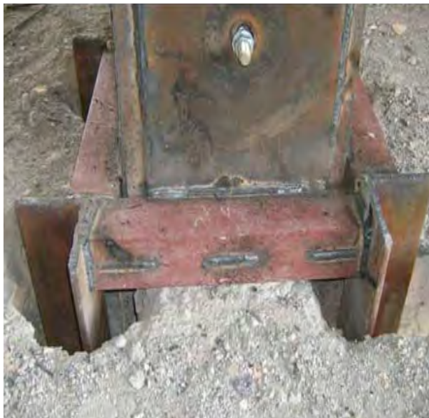
شکل ۲-۵-۱۲- نمونه‌ای از روکش فولادی جهت افزایش مقاومت خمشی ستون
