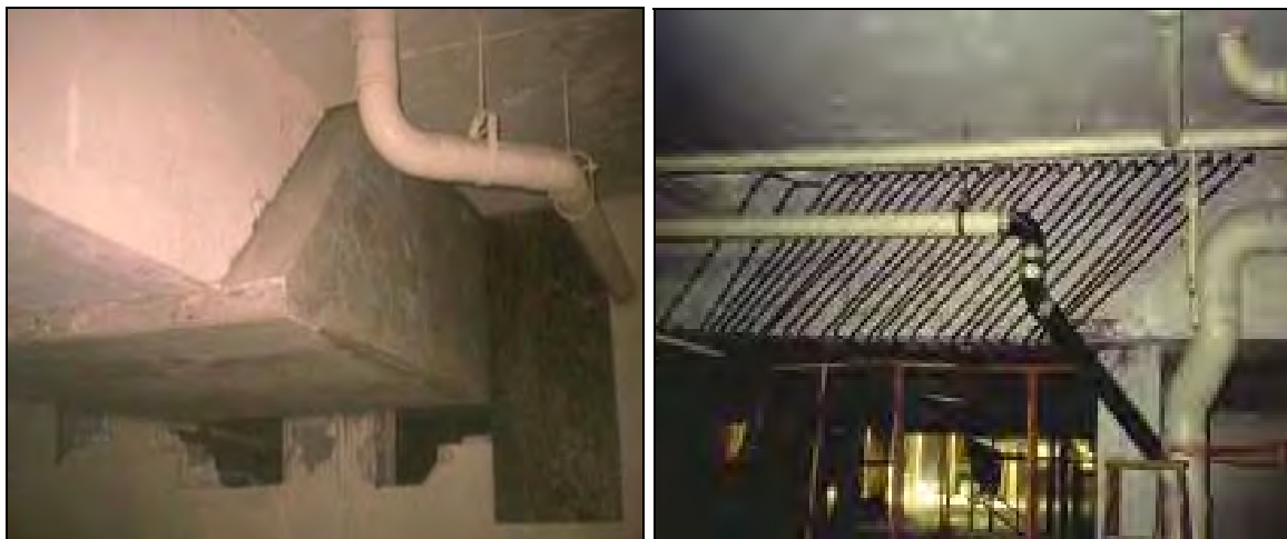
شکل ۲-۴-۴- استفاده از روکش بتنی در مقاوم‌سازی تیرها
