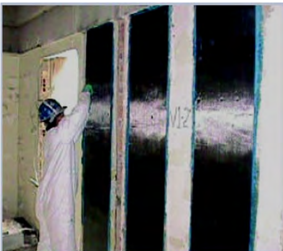
شکل ۸-۱۹ - نحوه اجرا و نصب نوارهای FRP
