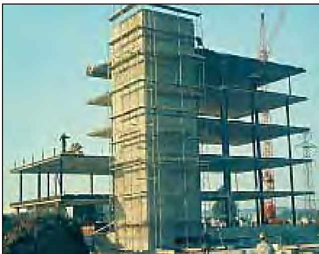
شکل ۳-۶- فاصله زیاد بین مرکز جرم و مرکز سختی و خرابی ناشی از ایجاد پیشش
