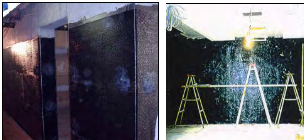
شکل ۴-۴۲- تقویت کلی دیوارهای برشی بوسیله مصالح FRP
