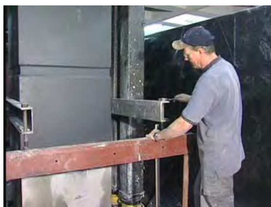
شکل ۶-۱۸ - نصب سازه خرپایی نگهدارنده
