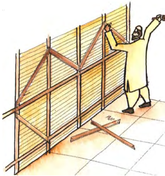
شکل ۹-۳۸ پیوستگی اعضای قطری
