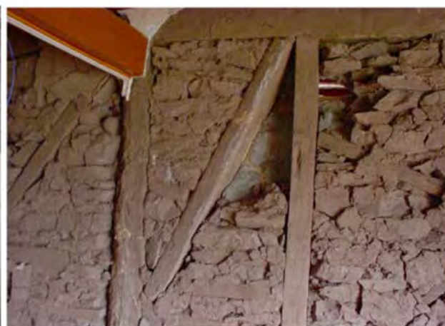
پ: ریزش تکه‌هایی از مواد پرکننده
