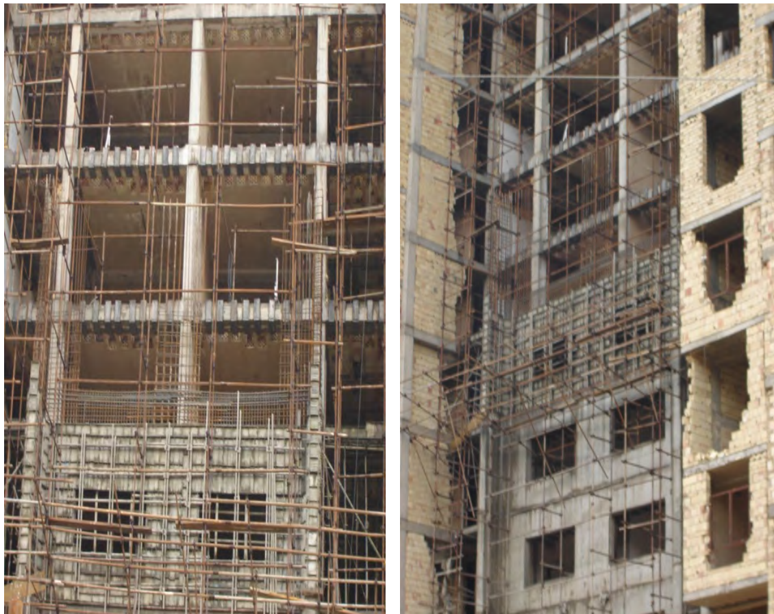
شکل ۴-۴۷ - افزودن میانقاب بتنی به عنوان دیوار برشی
