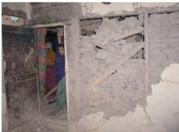
پ: ریزش تکه‌هایی از مواد پرکننده
