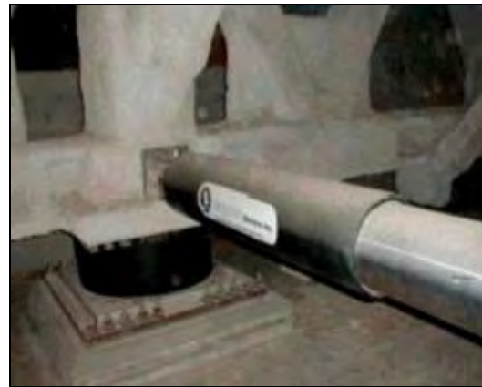
شکل ۷-۱۶- جزئیات تیپ سیستم میراگر ویسکوز
