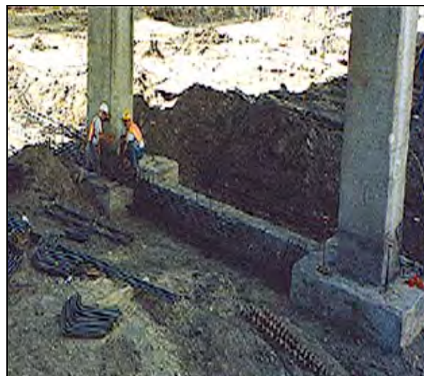
شکل ۴-۲-۲ - به هم بستن شالوده‌ها با شناژ
