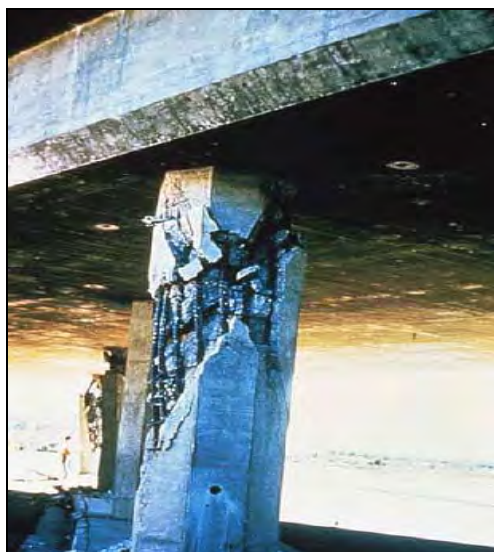
شکل ۲-۵-۱- نمونه‌ای از شکست برشی ستون
