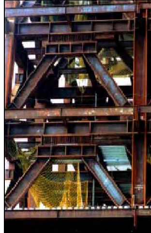
شکل ۷-۱۳- نمونه هایی از بکارگیری میراگر T-ADAS
