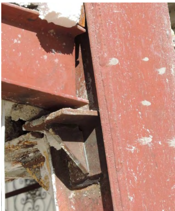
شکل (۴-۲۸): جدا شدن تیر از نبشی نشیمن
