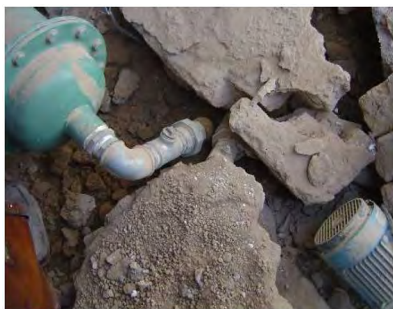
شکل (۴-۸): آسیب وارده به تأسیسات ساختمان ناشی از سقوط
