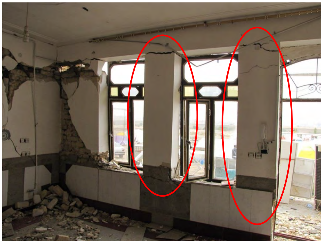
شکل (۶-۱۲): نا شاقول بودن اعضای باربر ثقیلی در یک ساختمان مصالح بنایی بدون کلاف
