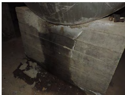
شکل (۸-۱): نشت مواد ذخیره‌ی مخازن، ریختن مواد شیمیایی خطرناک
