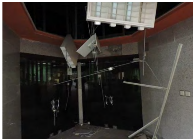
شکل (۸-۲): خطر سقوط سیستم سقف و وسایل روشنایی
