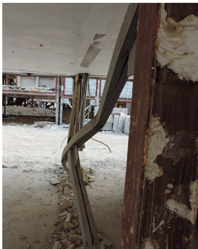
شکل (۴-۱۶): تسلیم مهاربند
