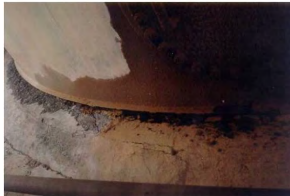
شکل (۸-۱): نشت مواد ذخیره‌ی مخازن، ریختن مواد شیمیایی خطرناک
