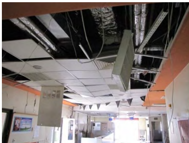
شکل (۸-۲): خطر سقوط سیستم سقف و وسایل روشنایی
