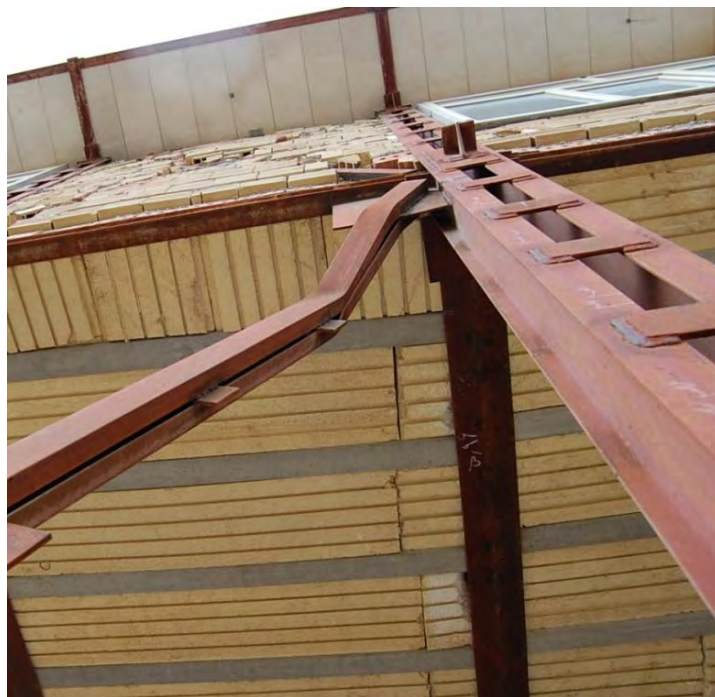
شکل (۴-۱۸): کمانش مهاربند
