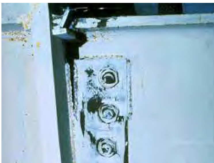
شکل (۴-۳۰): شکست پیچ
