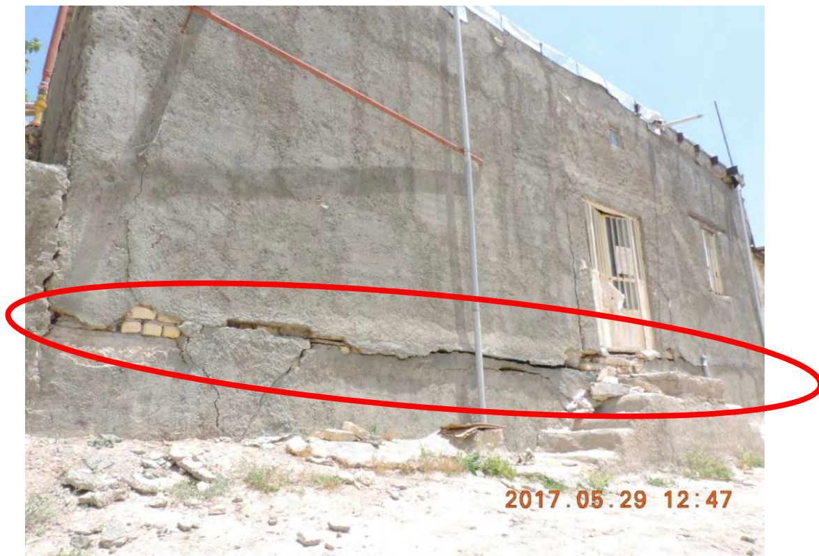
شکل (۵-۶): نمونه‌ای از شکست به وجود آمده در پی به صورت جداشدگی دیوارها از کرسی چینی
