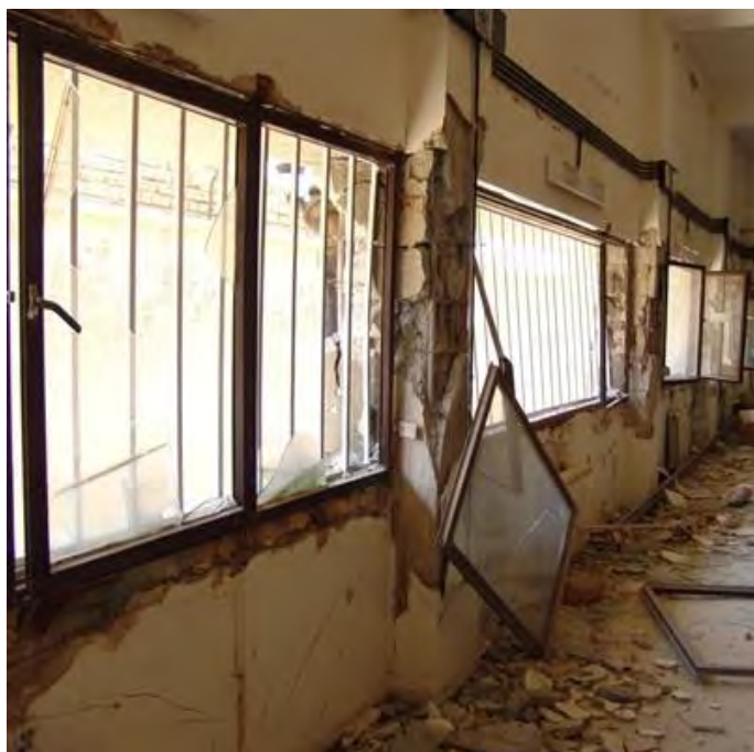
شکل (۵-۵): شکل‌گیری رفتار ستون کوتاه به علت کاهش طول آزاد در ستون بتن مسلح
