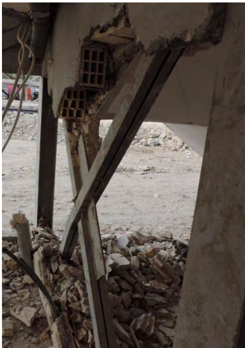
شکل (۴-۱۹): کمانش و طولیل شدگی مختصر مهاربند
