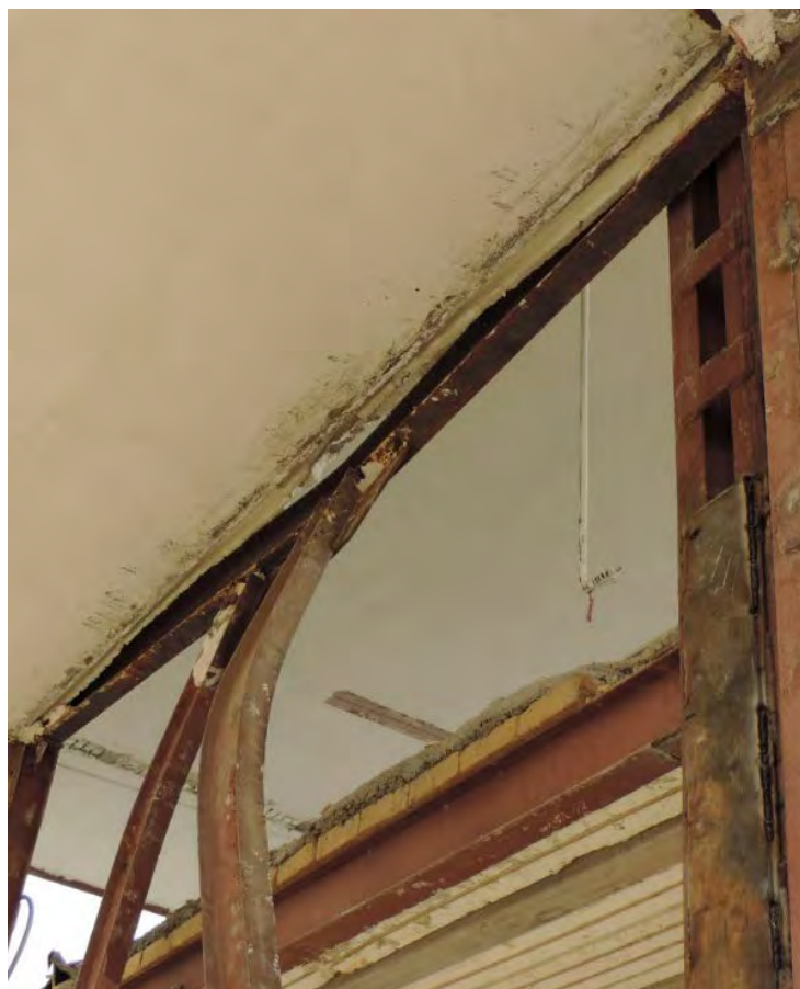
شکل (۴-۲۰): کماتش مهاربند در سیستم مهاربندی واگرا
