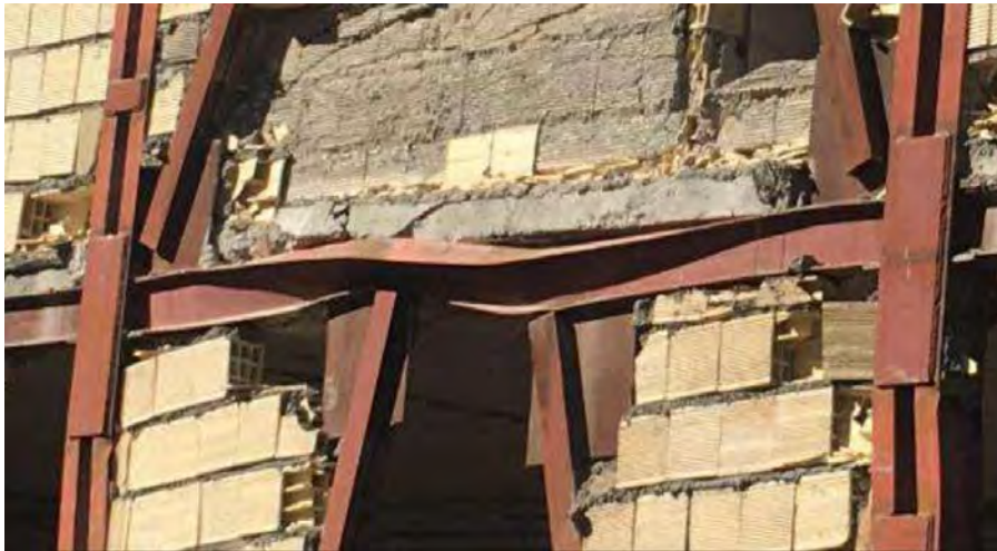
شکل (۲۲-۴): کمانش پیچشی-جانبی و له شدگی تیر پیوند
