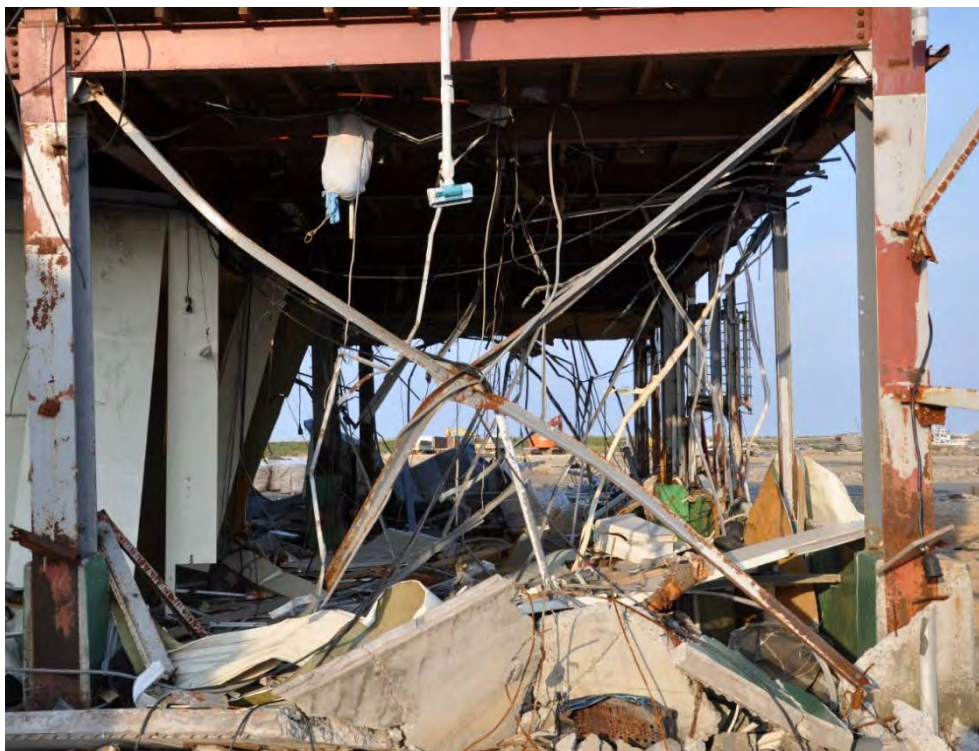
شکل (۴-۱۷): تسلیم مهاربند در ساختمان صنعتی
