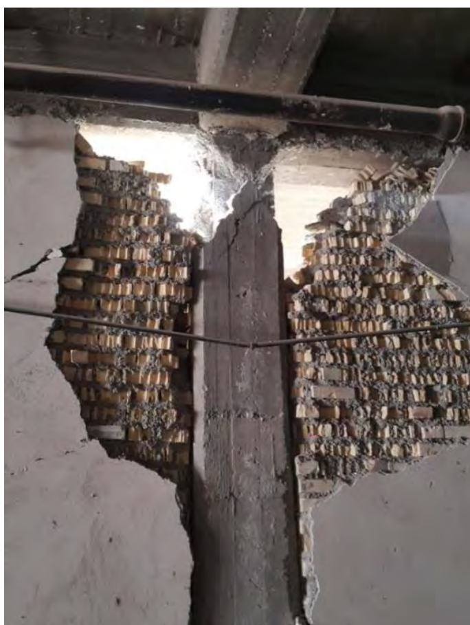
شکل (۵-۶): شکل‌گیری رفتار ستون کوتاه به علت تخریب کنج میانقاب مصالح بنایی متصل به قاب
